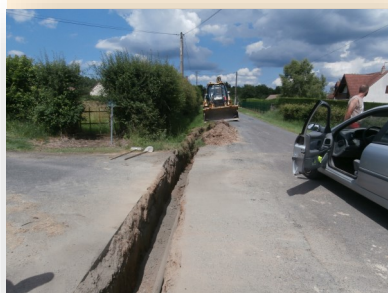
Syndicat d'eau : route des tripaudières renforcement des canalisations
