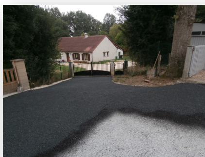
Réfection par gravillonnage d'une impasse chemin de bois brun : financement par la commune
